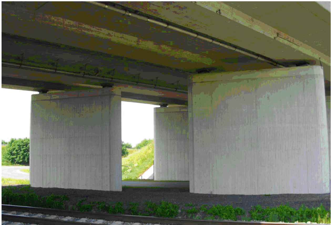
Foto: Untersicht Überbau mit Entwässerungsleitungen 2013
