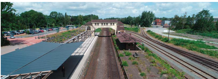
Der stillgelegte Mittelbahnsteig sowie die Bahnsteigbrücke werden im Rahmen der Elektrifizierung zurückgebaut.
