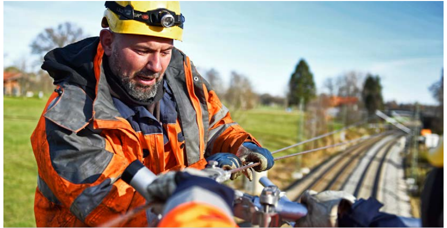
Arbeiten zur Elektrifizierung der Strecke (Beispielbild)
