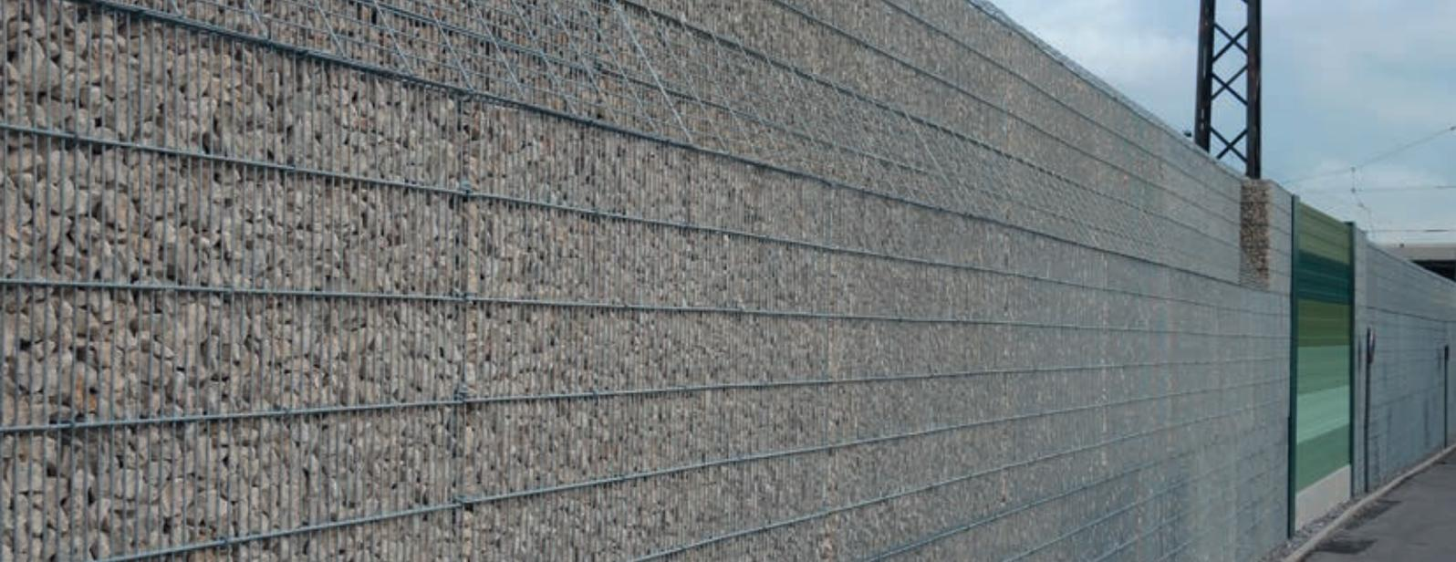
Eine Gabionen-Schallschutzwand besteht aus Drahtkörben, die mit Steinen befüllt werden. Gabionenwände sind schallabsorbierend, fügen sich natürlich in die Umgebung ein und bieten Unterschlupf für Kleinlebewesen.
